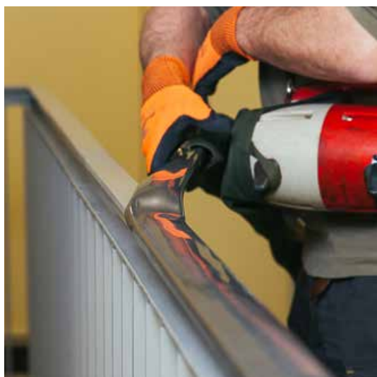
HL gleichmässig Erwärmen mit Durchlauferhitzer mit Luftschlauch.
