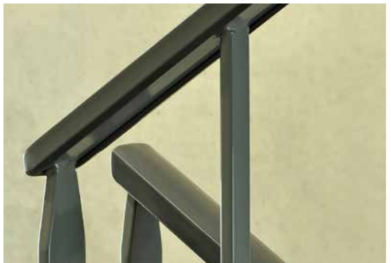
Die Staketen und Konsolen sind innerhalb der Profilöffnung zu platzieren.
